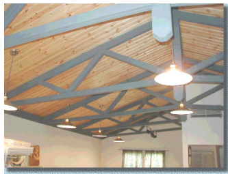
屋根形トラス構造
